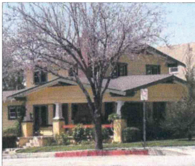
H. Front wrap-around porch
