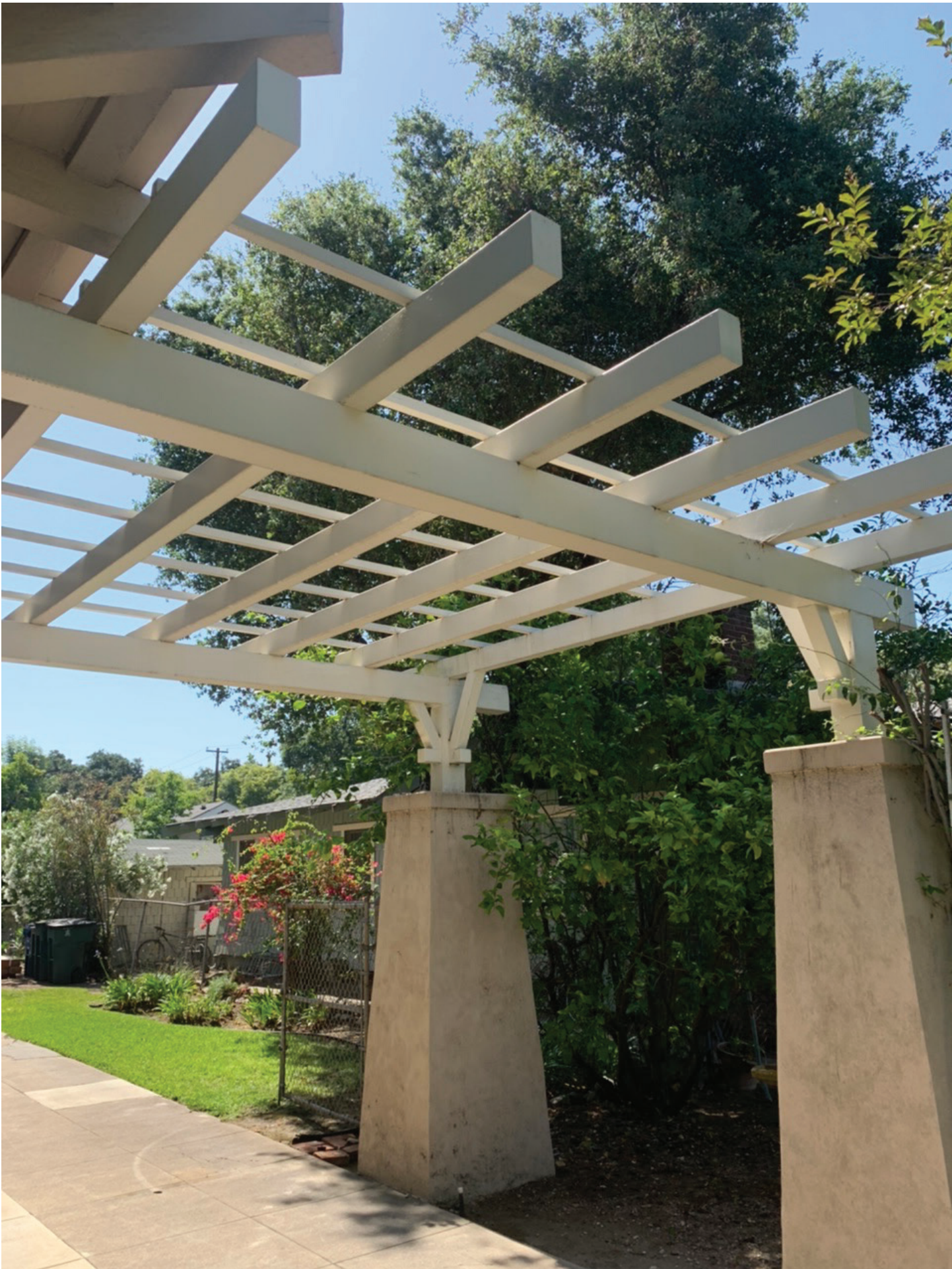
1500 N. LOS ROBLES AVE: PORTE COCHERE
