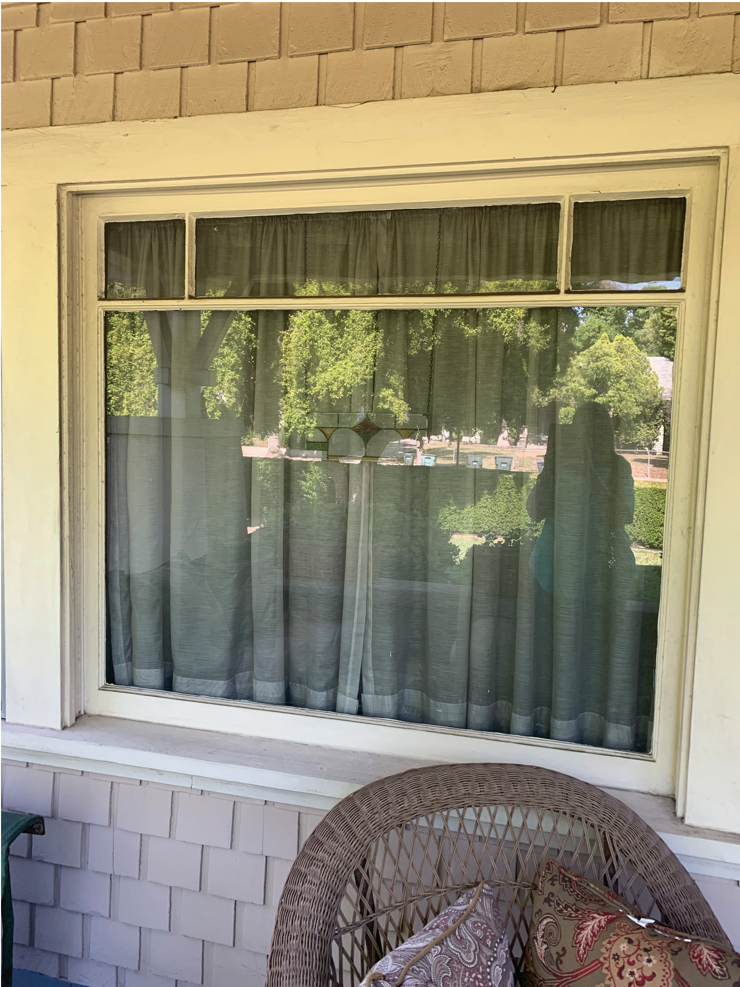
1500 N. LOS ROBLES AVE: FRONT PORCH WINDOWS
