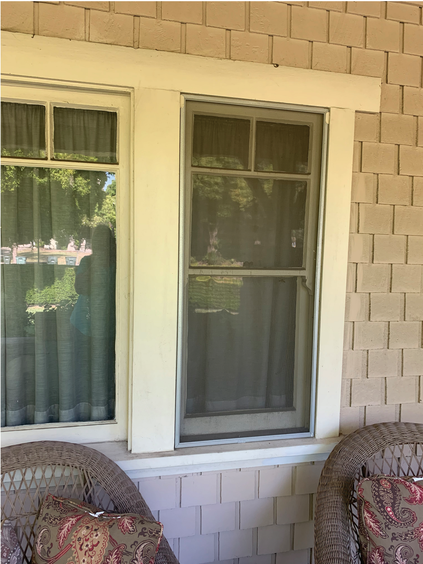
1500 N. LOS ROBLES AVE: FRONT PORCH WINDOWS
