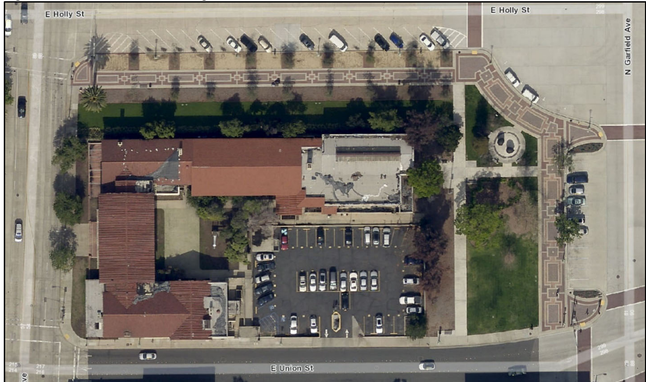
Figure 9: Aerial of YWCA Building / YWCA Site
