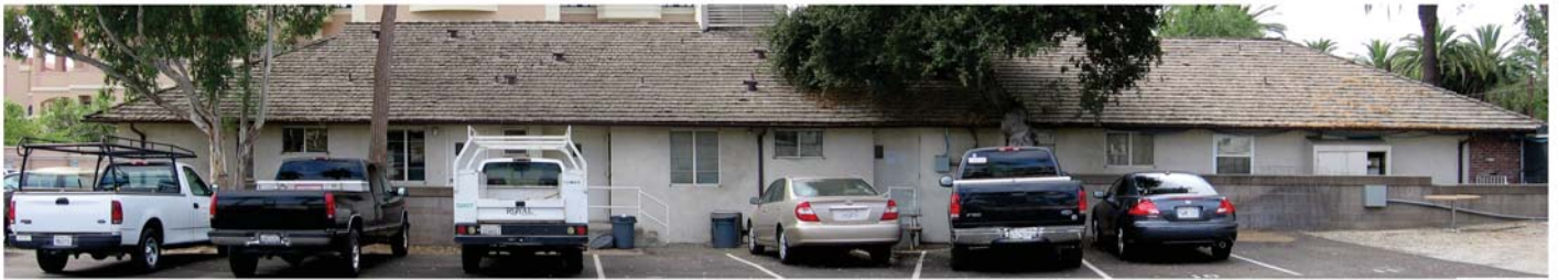
624 S. Pasadena Avenue - North Elevation
