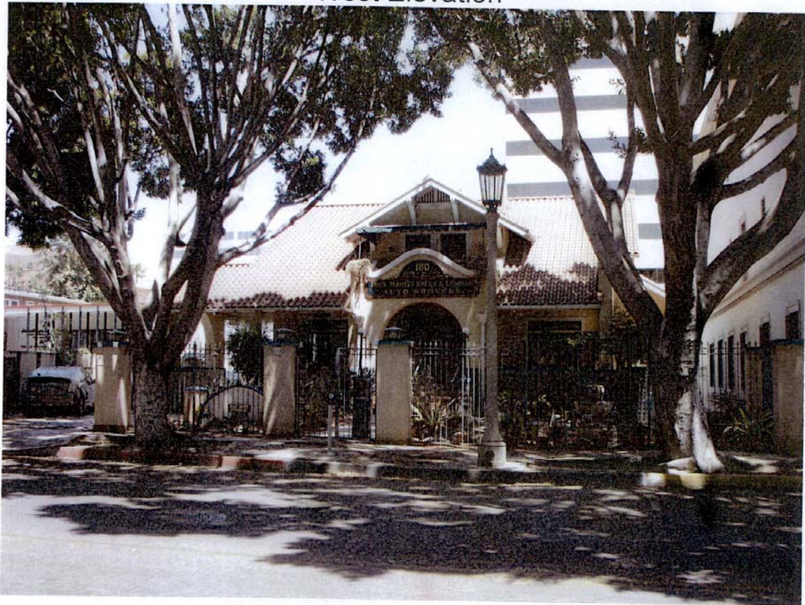
180 S. Euclid Avenue West Elevation
