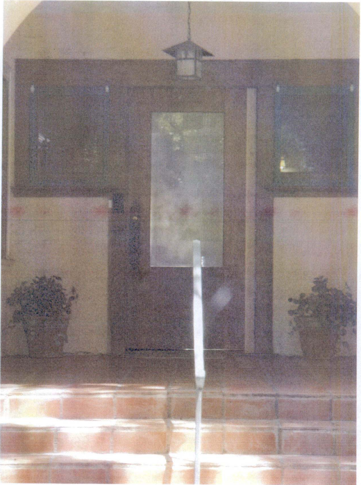
180 S. Euclid Avenue Front Door Detail
