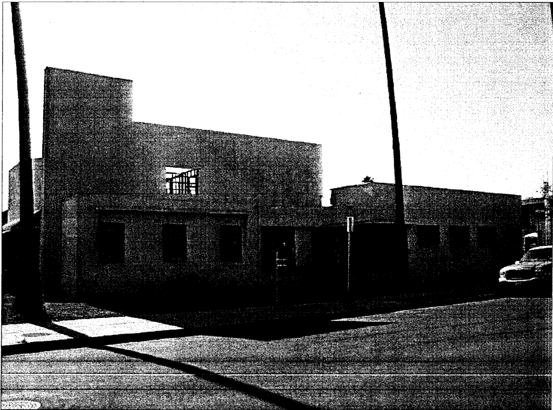
N. Parkwood Avenue elevation
