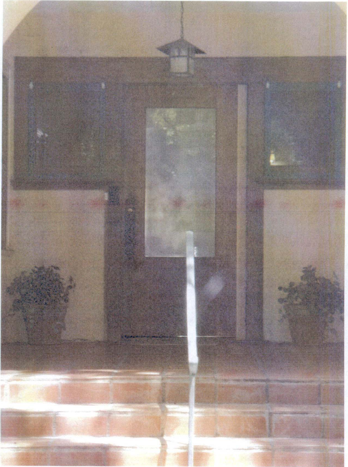
180 S. Euclid Avenue Front Door Detail
