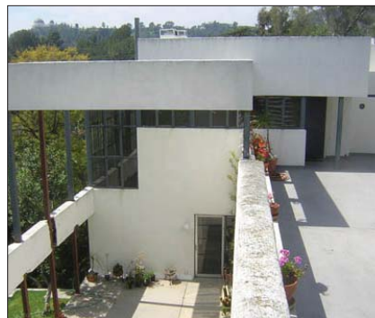
E. Roof garden.
