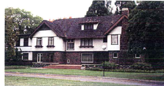
2A - Manor Del Mar - bldg 20
